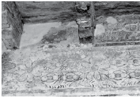
Casa Petrarca di INFERNUM/LINTERNO (XIV sec.) Soffitti lignei e parete affrescata con motivi floreali
